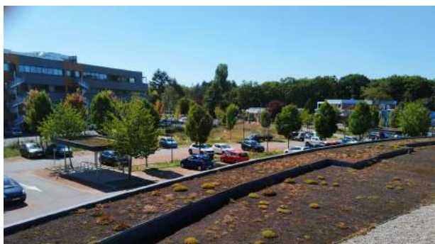
Centre technique de la Roannaise de l'eau
